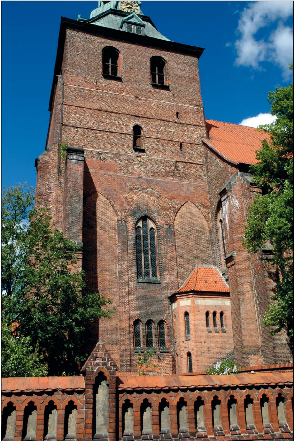
Ryc. 16. Lüneburg, St. Michaelis. Westturm von Südwesten mit Schildbogenvorlagen an der Südwand und dem bei der Sanierung von 1903-1907 verstärkten Mauerwerk der Westwand (2004). Photo H. Rümelin
