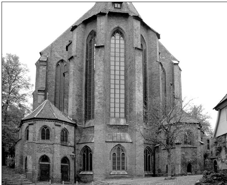
Ryc. 10. Lüneburg, St. Michaelis. Choranlage von Osten. Langchor mit Hallenkrypta flankiert von Sakristeien über Nebenkrypten (2005). Photo H. Rümelin
